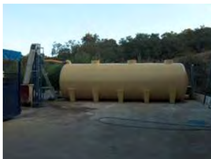
Filtro biológico para un matadero en Jabugo, (Huelva)
