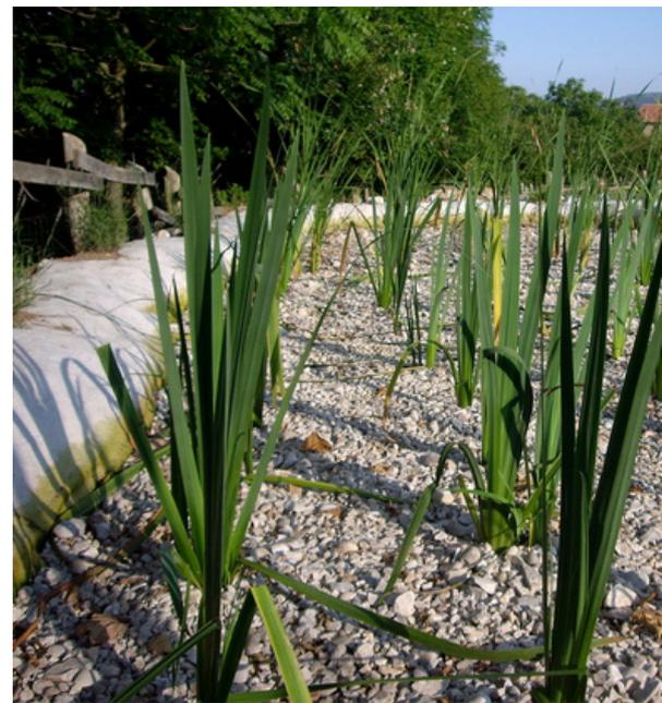
Al igual que en nuestro exclusivo sistema de flujo sumergido horizontal con material plástico filtrante, también en la fitodepuración de tipo francés la superficie necesaria es notablemente inferior respecto a los sistemas convencionales de tipo horizontal y vertical.
